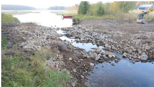
Bild: Efter åtgärd 2014-09-13
