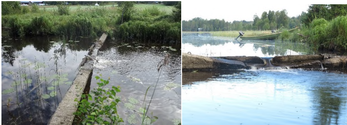
Bild: Tidigare betongtröskel
