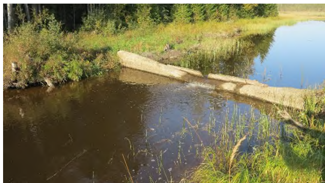
Bild: Före åtgärd 2014-09-13
